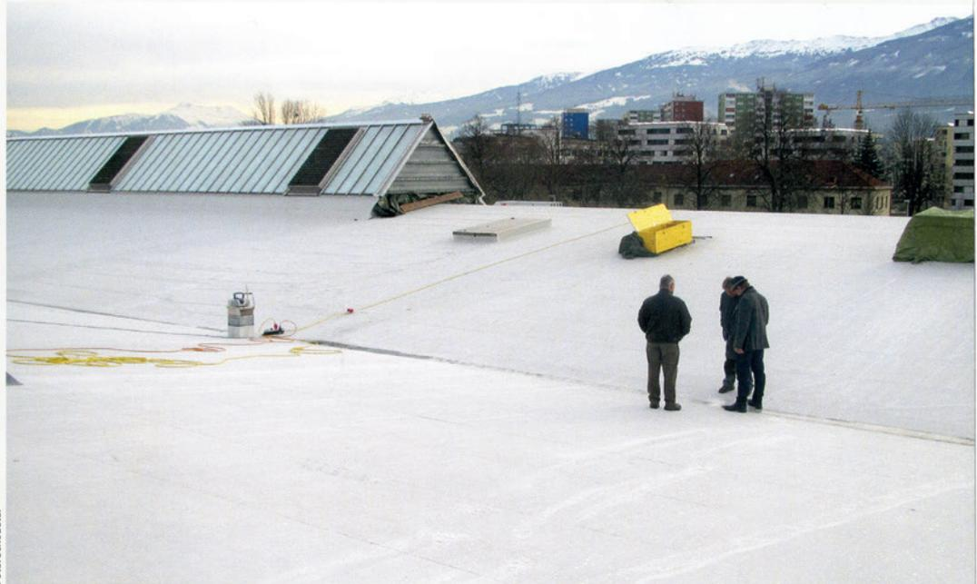
Begehung bei Frost: Große Teile der Dachfläche sind bereits fertiggestellt. Die Oberlichter (zur Brauchrauchentlüftung) im Firstbereich erhielten eine neue Verglasung, RWA-Technik und eine Metallbekleidung.
