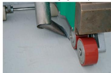
FPO-Kunststoffdichtungsbahn „ExtruPol M“ in der Fläche verlegt: lose verlegt, mechanisch befestigt
