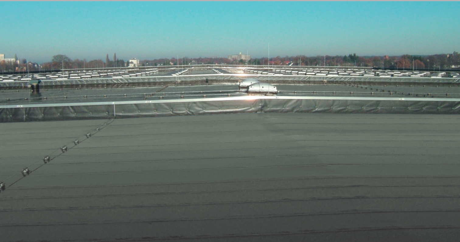
Centro de logística Lidl, em Leverkusen (Alemanha), manta ExtruBit, 33.000 m 2
