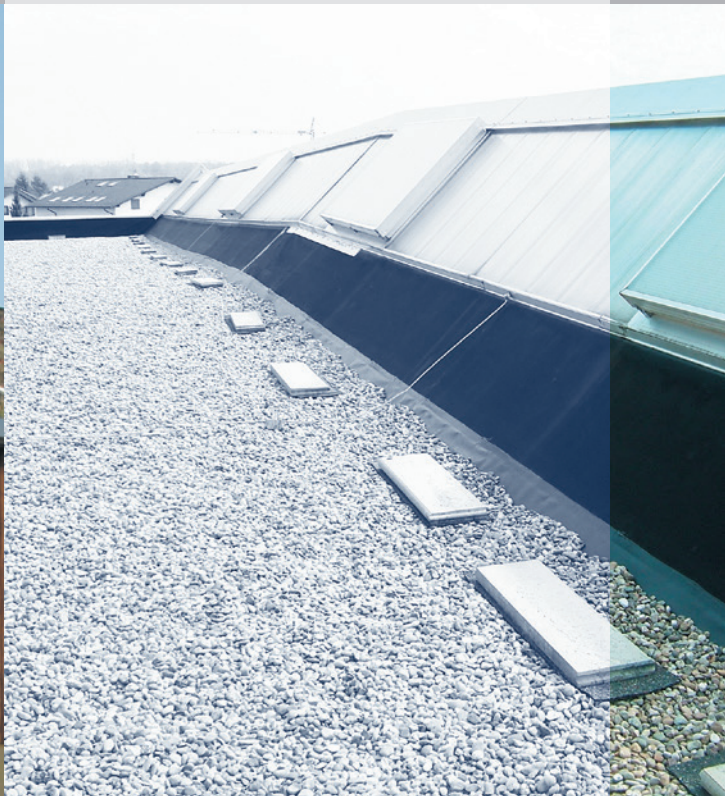
Loja de materiais de construção, em Baden-Baden (Alemanha) impermeabilização de cobertura com ExtruBit, 4.500 m 2
