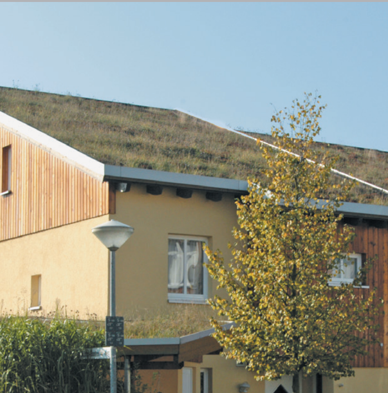
Condomínio com telhados verdes, em Bovenden (Alemanha) impermeabilização de cobertura com ExtruBit, 850 m 2
