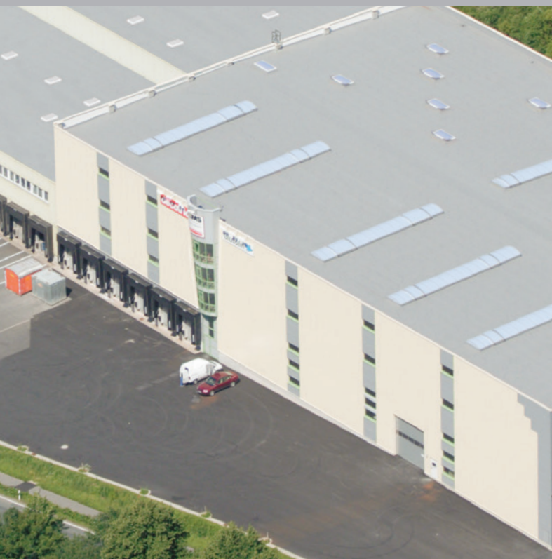
Fábrica da Pufas, em Hann. Münden (Alemanha) impermeabilização de cobertura com ExtruPol, 7.100 m 2
