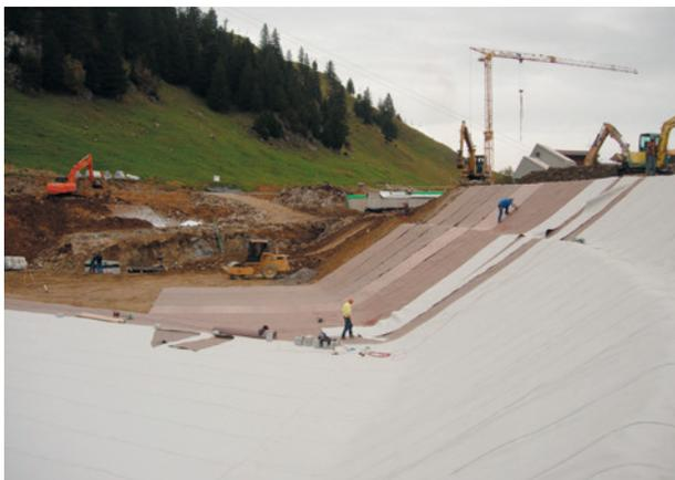
Verlegung der Dichtungsbahnen auf dem Geotextil.
