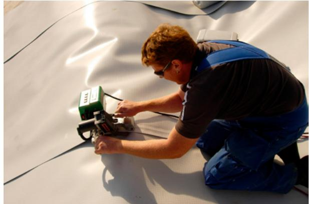
Einsatz des Schweißautomaten bei Böschungsübergang.
