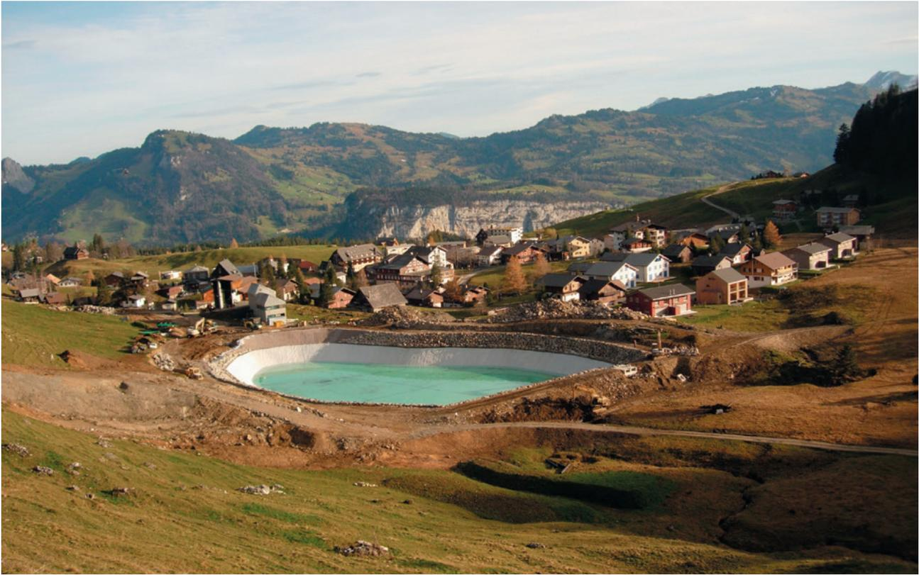
Speicherbecken: Abdichtung mit Dichtungsbahnen von SCHEDETAL.
