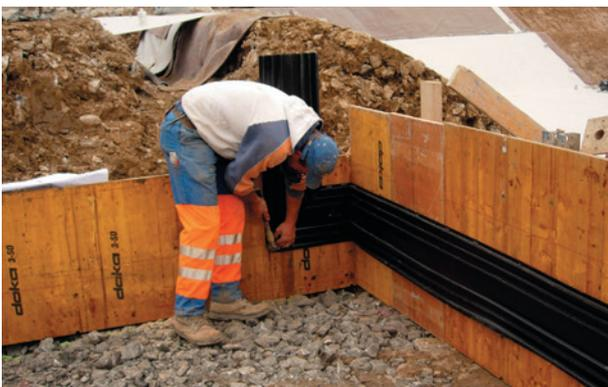
Einbau Fugenband in Schalung.
