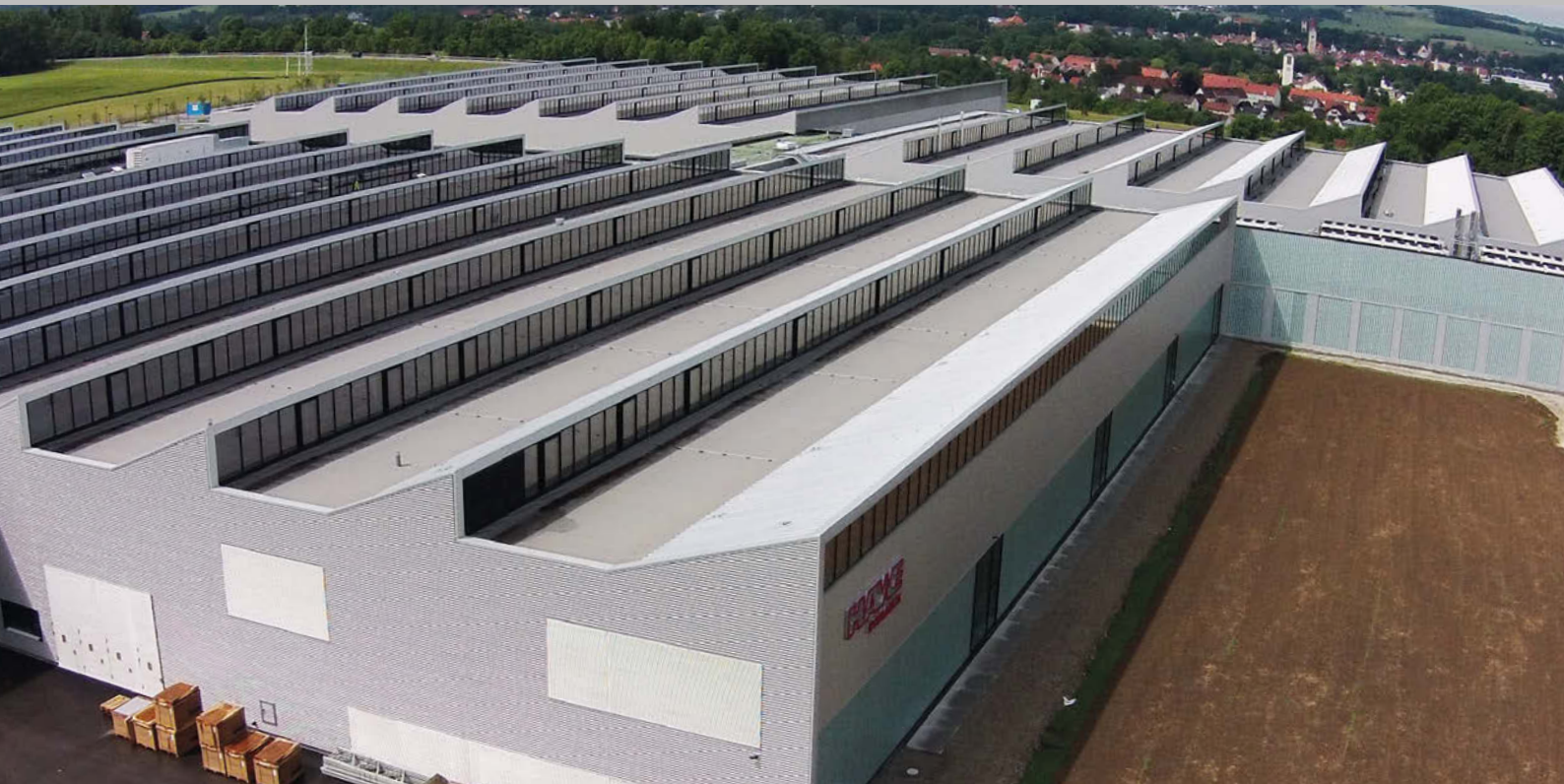
HAWE Hydraulik, Kaufbeuren, ExtruPol Dachabdichtung, 40.000 m 2
