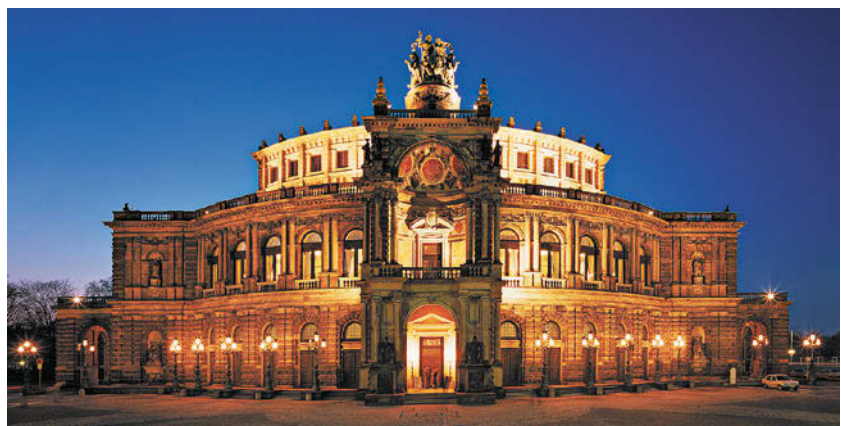
Semper Oper Dresden, ExtruBit Dachabdichtung, 1.800 m 2
