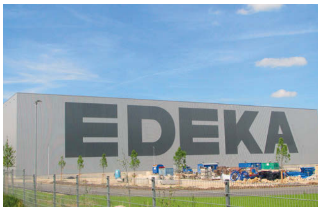
EDEKA, Landsberg, ExtruPol Dachabdichtung, 27.000 m 2
