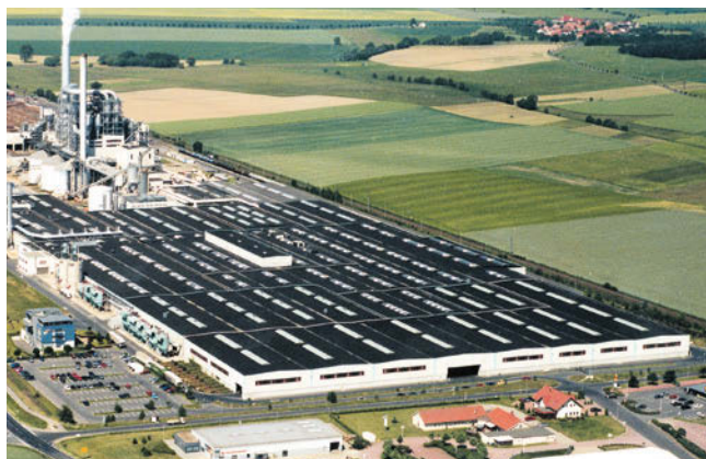
Kronospan, Lampertswalde, ExtruBit Dachfläche, 117.000 m 2
