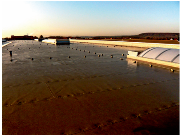
Schedetal SystemFlachdach in Filderstadt.
