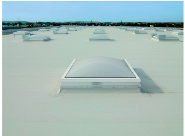
Schedetal SystemFlachdach in Nürnberg.
