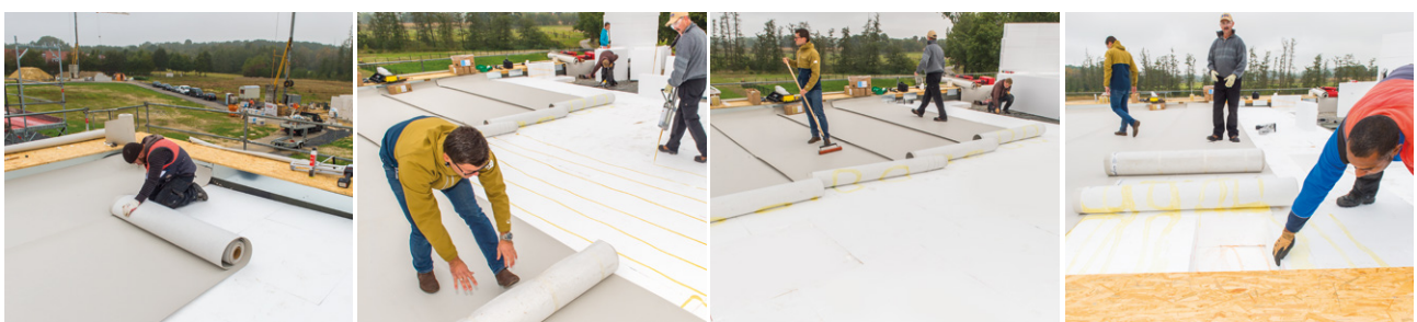
Bahnen erst ohne Kleber ausrollen und zuschneiden, Bahnen ausrollen und z.B. mit einer anderen Bahnrolle andrücken.
