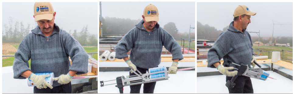
Einfache Montage: Spritzdüse auf Kartusche aufschrauben, dann ins Gestell der Klebepistole einsetzen - fertig.
