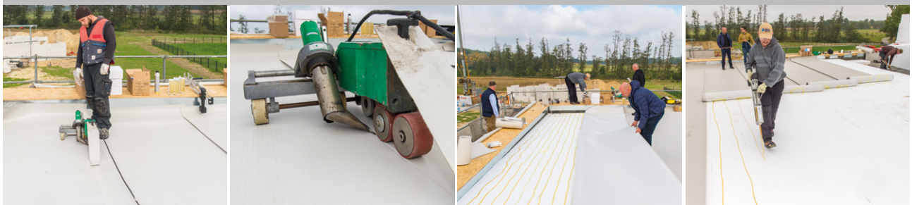
Nähte wie üblich mit Heißluft verschweißen. Der Millennium Kleber PG1 ist sicher und unschlagbar schnell.
