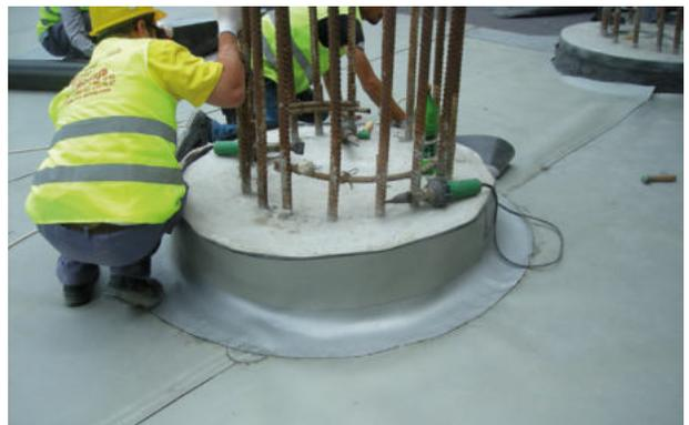
11. Verschweißen der Schedetal Abdichtungsbahn ExtruThere® mit dem Fugenband
