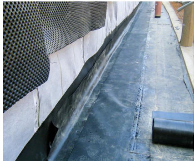
Bild 4 stellt typische Schichtenfolgen der Abdichtung erdberührter Wände bei W2.1-E und W2.2-E dar.
