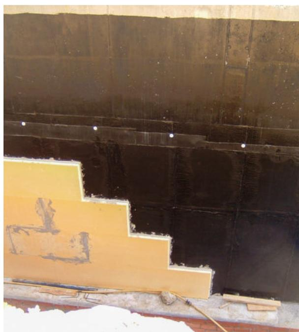
Ist es konstruktiv notwendig, zur Aufnahme von Horizontal-lasten Widerlager einzubauen, kann die Querschnittsabdichtung mit stufenförmigem Verlauf angeordnet werden
