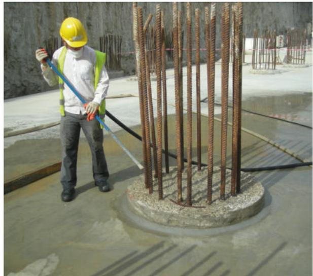
2. Reinigen des Bohrpfahlkopfes mit Hochdruckreinigern um alle losen Partikel zu entfernen
