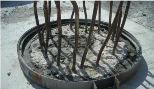
5. Auf einem Spannelement aus Metall das Fugenband am Bohrfahlkopf sichern
