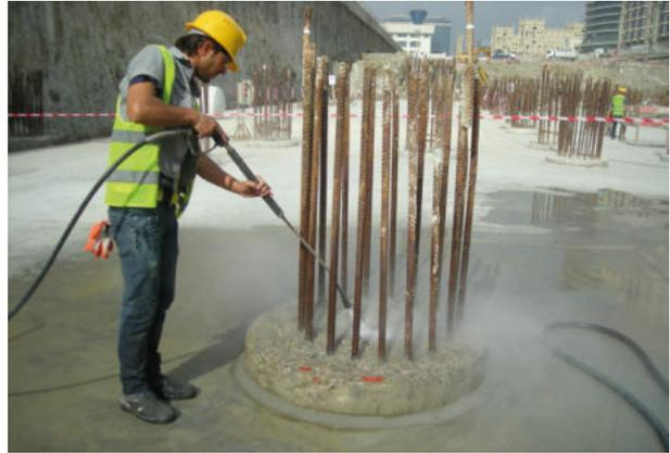
1. Grobe Verunreinigungen von Betonpartikeln entfernen
