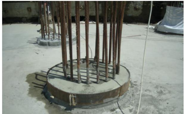
9. Schedetal wasserundurchlässigen Beton aushärten und trocknen lassen
