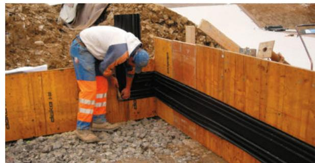
Einbau Fugenband in Schalung
