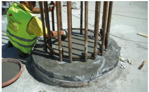
10. Entfernen des Spannelements aus Metall vom Fugenband
