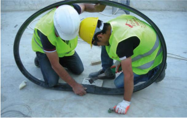
4. Fugenband für Bohrfahl-Abdichtung vorbereiten
