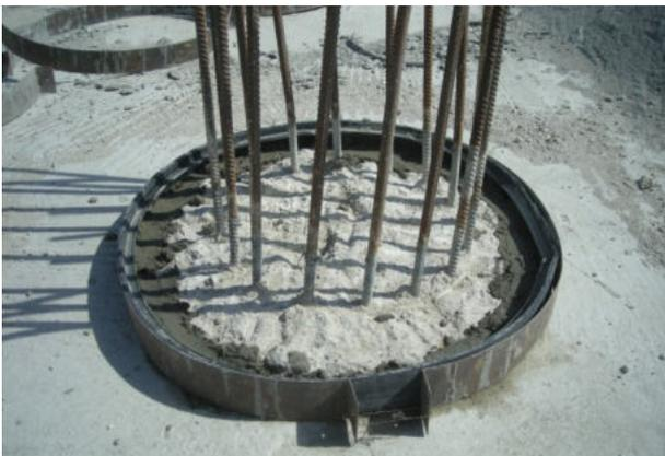
6. Erste Lage Schedetal wasserundurchlässigen Beton aufbringen und verdichten
