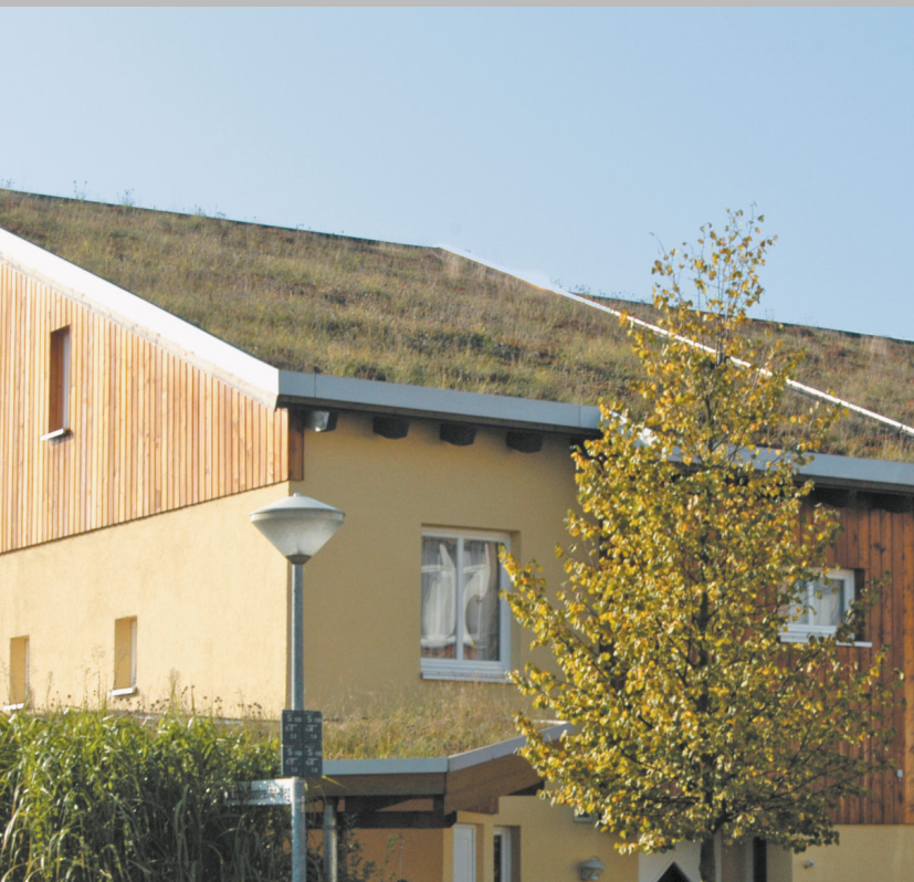
Gründach-Siedlung Bovenden ExtruBit-Dachabdichtung, 850 m 2
