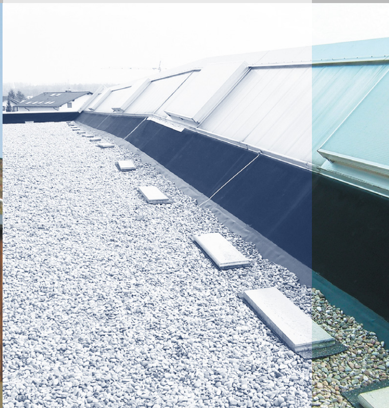
Baumarkt, Baden-Baden ExtruBit Dachabdichtung, 4.500 m 2
