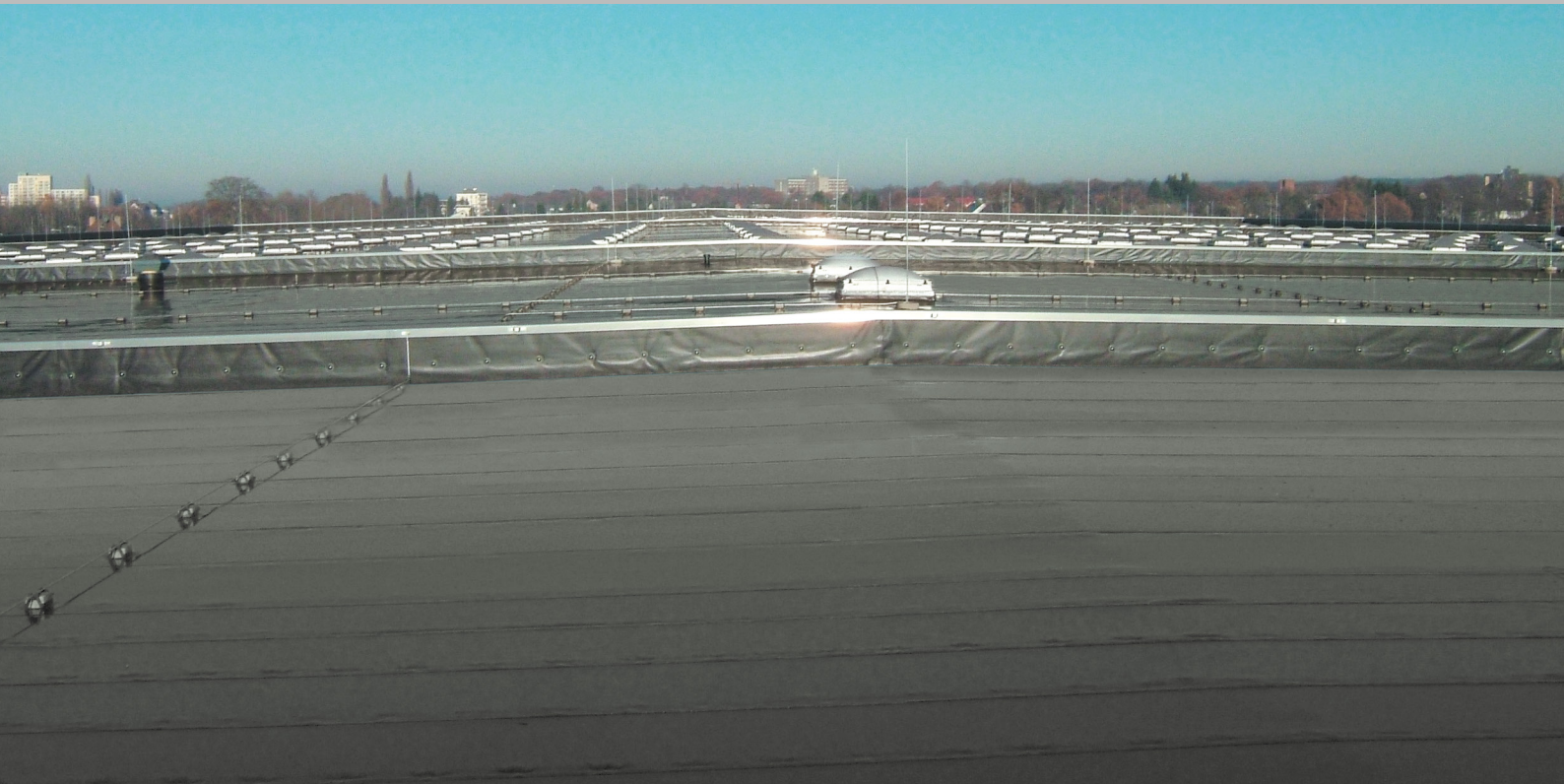
Lidl Logistikzentrum, Leverkusen ExtruBit Dachabdichtung, 33.000 m 2
