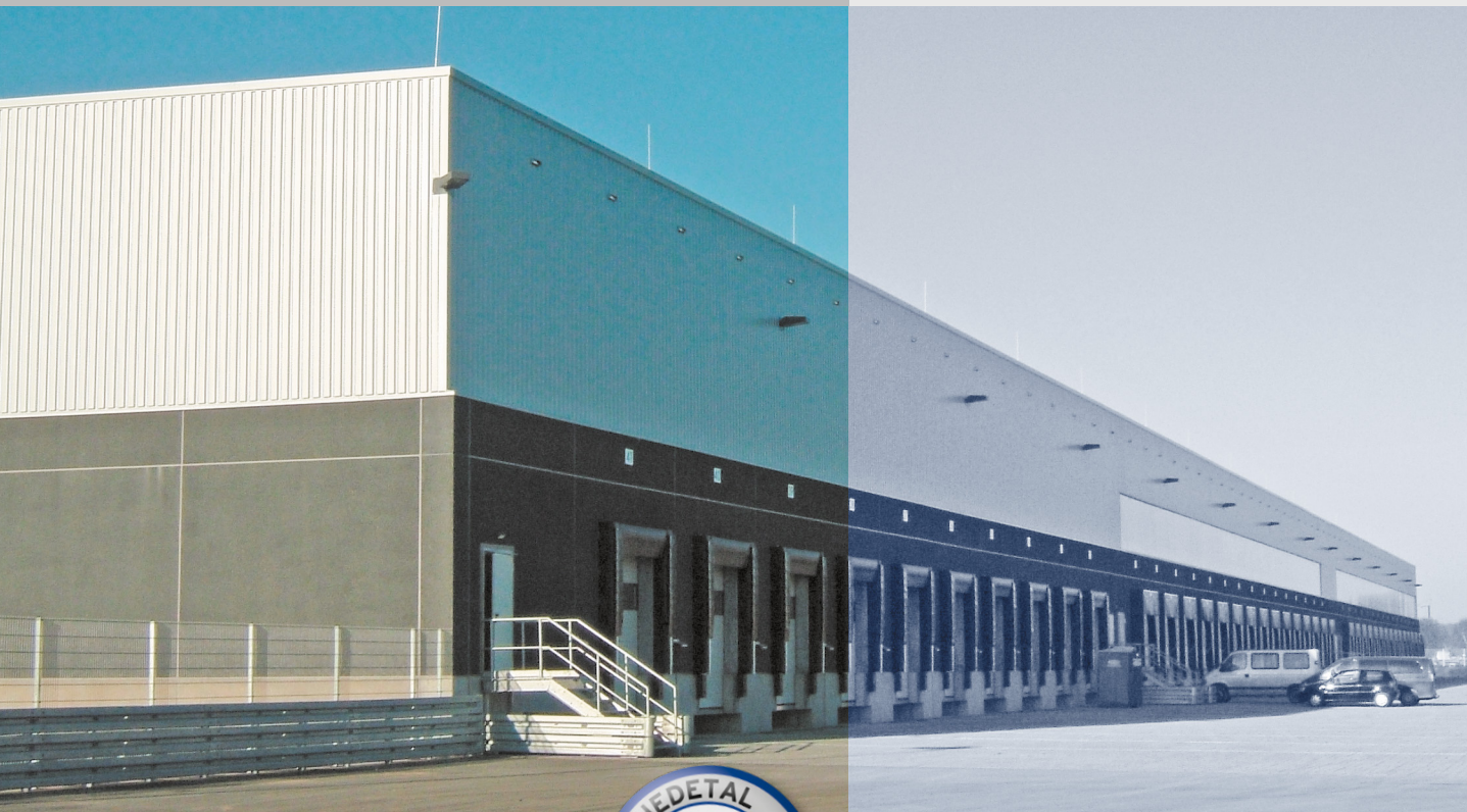
Lidl Logistikzentrum, Leverkusen ExtruBit Dachabdichtung, 33.000 m 2
