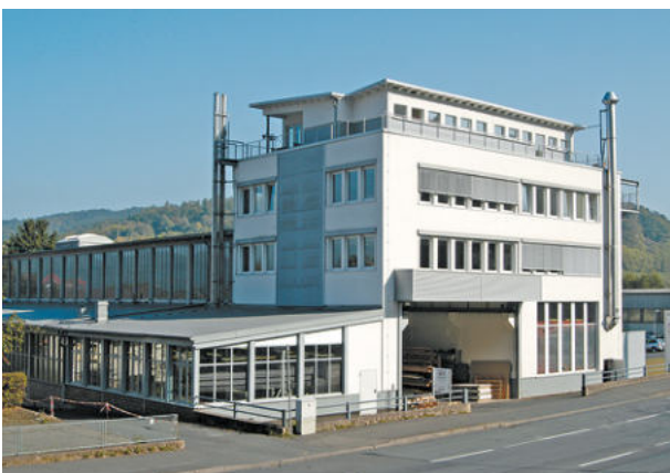
HTT Hann. Münden, ExtruPol Dachabdichtung, 4.000 m 2
