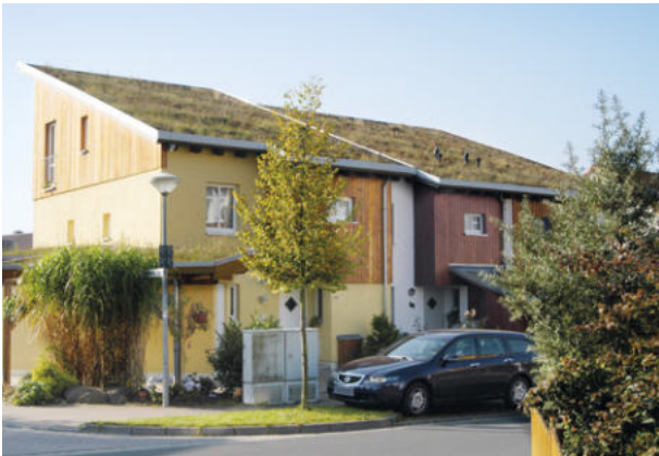
Gründach-Siedlung Bovenden, ExtruBit Dachabdichtung, 850 m 2
