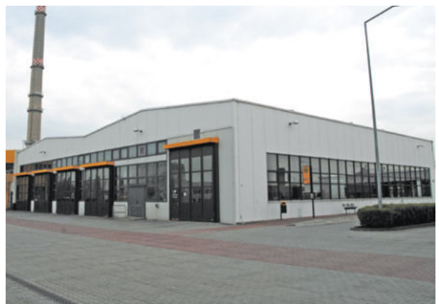
DVB Dresdner Verkehrsbetriebe AG, ExtruBit Dachabdichtung, 10.000 m 2 ; ExtruPol Dachabdichtung, 4.000 m 2
