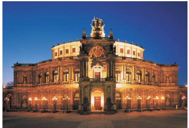
Semper Oper Dresden, ExtruBit Dachabdichtung, 1.800 m 2
