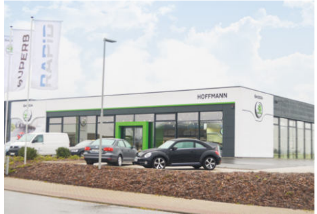
Autohaus Hoffmann in Burgwald, ExtruPol Dachabdichtung 1.000 m 2
