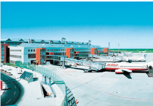
Flughafen Dresden, ExtruPol Dachabdichtung, 6.350 m 2
