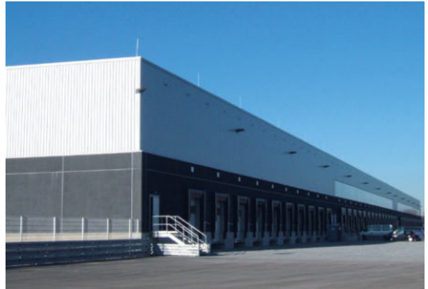
Lidl Logistikzentrum Leverkusen, Extrubit Dachabdichtung, 33.000 m 2
