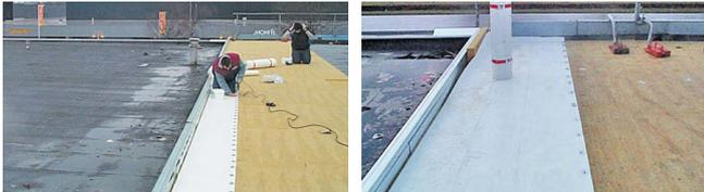
Im nächsten Schritt wird die nächste Kunststoffdachbahn ausgerollt und gespannt, dann mittels Heißluftgerät mit mindestens 11 cm Überlappung verschweißt bevor die neue Fixierung für die mechanische Befestigung erfolgt. Mit diesem Vorgang können Diagonalfalten verhindert werden
